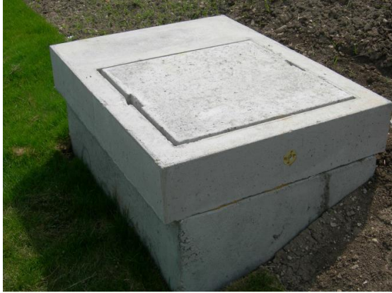
mit aufbetoniertem Schachthals
