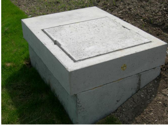
mit aufbetoniertem Schachthals
